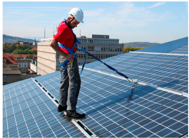
3 Zeitgemässe Photovoltaikanlage mit integrierter Absturzsicherung für Wartung und Unterhalt (als Rückhaltesystem zu verwenden)
