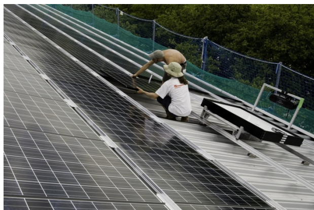
2 Die Montage von Kollektoren darf nur mit Kollektivschutz ausgeführt werden (Dachfangwand, Gerüst mit Spenglergang usw.).
