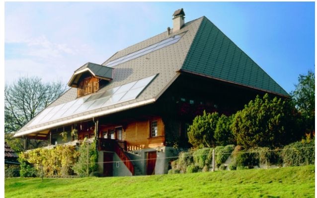
4 Eine für Solaranlagen ideale Dachneigung stellt höchste Anforderungen an die Zugangs- und Absturzsicherung.
